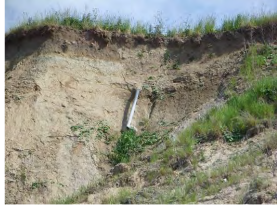
Altes Entwässerungsrohr in der Steilküste
