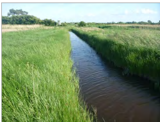
a) Entwässerung der ehemaligen Lagune
