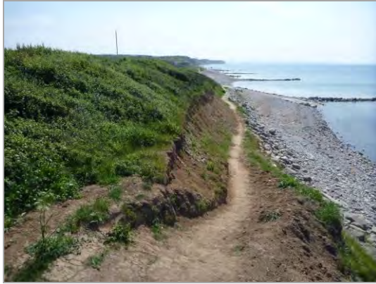
Befestigung des Steilufers / Wandelwitz
