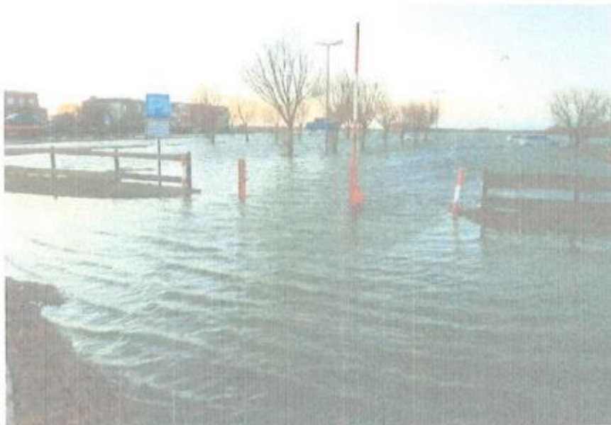
b) Das DLRG – Gebäude (links vom Leuchtmast) stand völlig unter Wasser , auf den Wiesen und Parkplätzen – hier hat das Salzwasser der Ostsee an PKW entsprechende Schäden verursacht. Rechts, über den PKW, auf dem Hochwasser ein Kyter!
