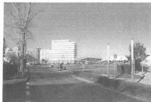
Standort 8 Blick von der südlichen Zufahrtsstraße
