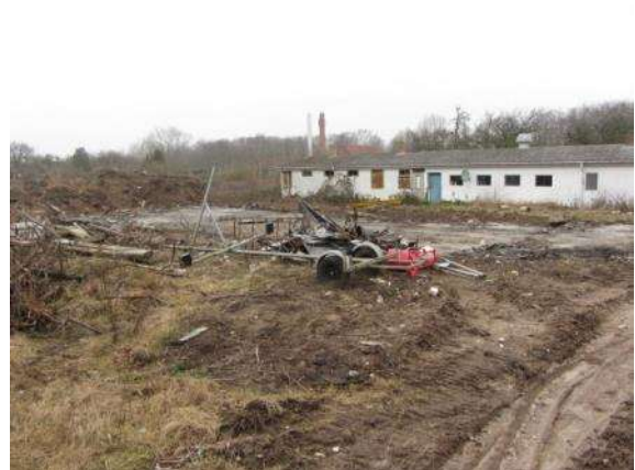
Foto 8: Gebäude 4 im Hintergrund, verblendet wie Gebäude 1-3
