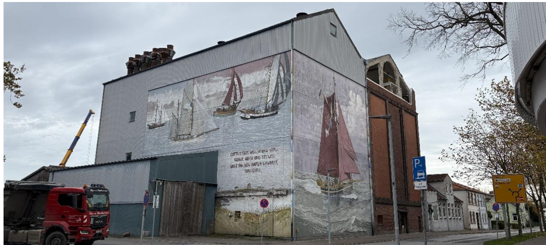
Abbildung 25: Standortalternative 4: Alter Speicher, Werftstraße
