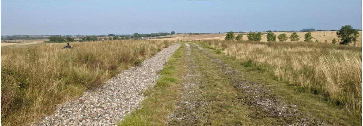
Foto auf dem Deponiekörper: Grasflur (RHg), Steinriegel zur Drainage des Oberflächenwassers (XWs/x) und mittig ein Schotterweg (SVt), Blickrichtung West
