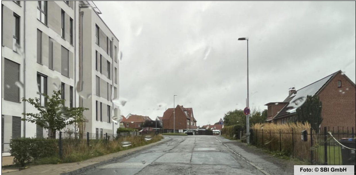
Abbildung 22: Weidestraße Gehweg abschnittsweise beidseitig in unzureichendem baulichem Zustand (eigene Aufnahme)
