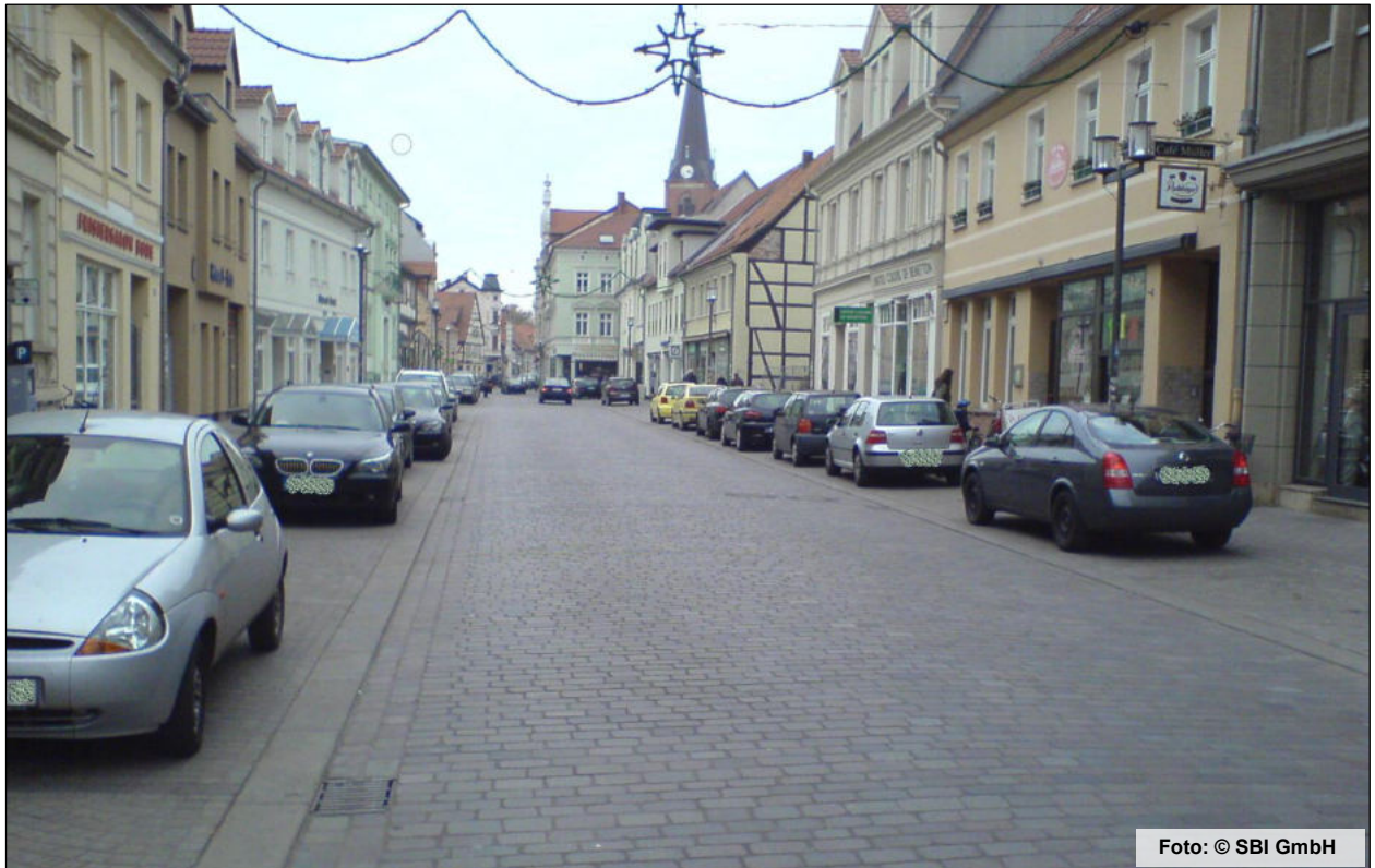
Abbildung 73: Beispiel – Pflaster mit geschnittener Oberfläche im Fahrbahnbereich (eigene Aufnahme)
