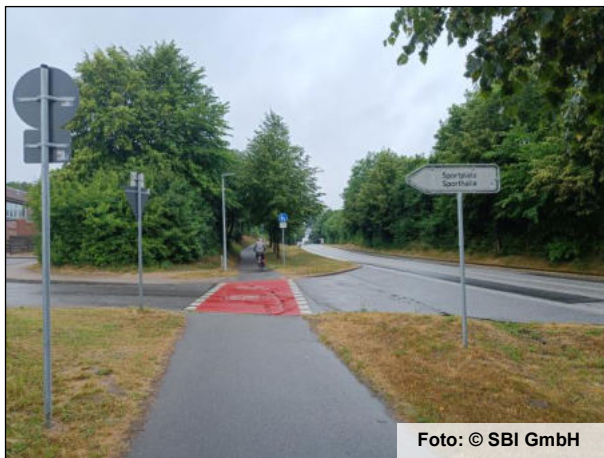
Abbildung 33: Roteinfärbung und Beschilderung von Furten mit Radverkehr in Gegenrichtung (ohne Benutzungspflicht – eigene Aufnahmen)
