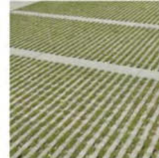
Rasenliner. Begrüntes und sicherfähiges Pflaster (grau) aus gefügichtigem Beton mit linearen Rasenfugen.
