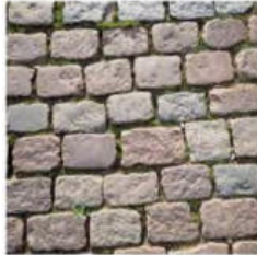
Granitgroßsteinpflaster rotbunt, Unregelmäßiger Reihenverband.
