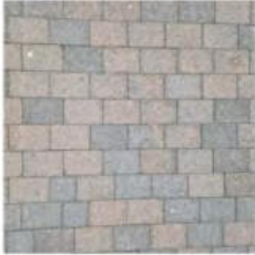
Betonsteinpflaster rotbunt: 1/3 Reihenverband.
