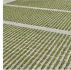
Rosenliner. Begrüntes und sickerfähiges Pflaster (grau) aus gefügedichtem Beton mit linearen Rasenfugen.
