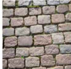
Granitgroßsteinpflaster rotbunt. Unregelmäßiger Reihenverband.
