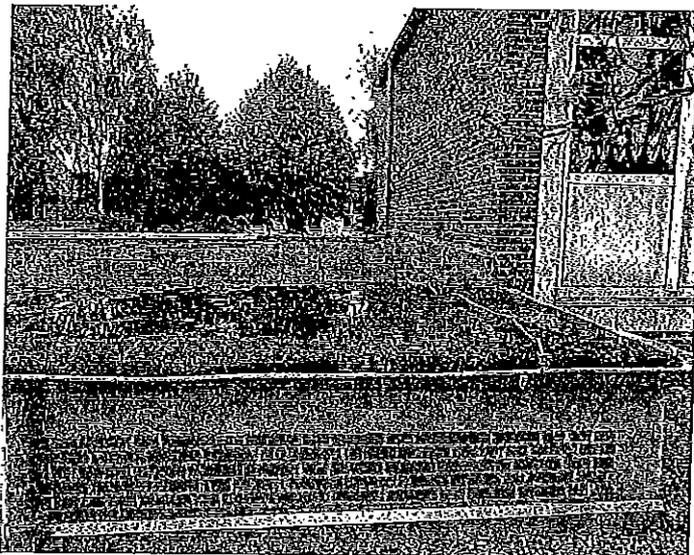
Teilweise ist ein anderer Wandaufbau vorhanden, hier ist die vermutete Konstruktion mit einem 24 cm Gasbeton-Blockstein ausgeführt. Die Konstruktion ist nicht gedämmt.
