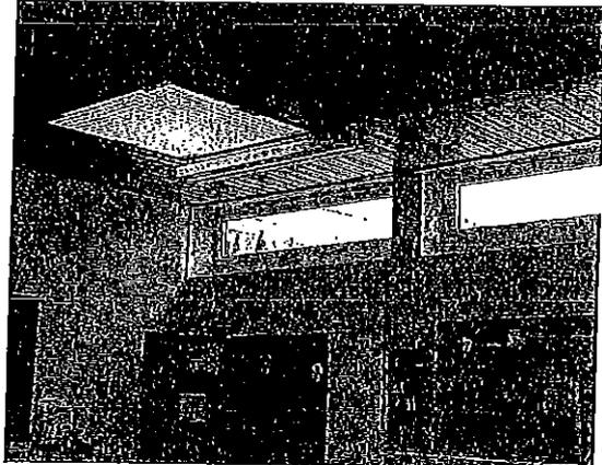
Die Sporthalle wird über ein zugeordnetes Lüftungsgerät belüftet und beheizt. Aufgrund der Luftführung unterhalb der Außenfenster ist eine direkte Beheizung des Aufenthaltsbereiches (Nutzbereich) nur mit einer Überheizung der Halle möglich. Es bilden sich zunächst Warmluftpolster unterhalb der Hallendecke.
